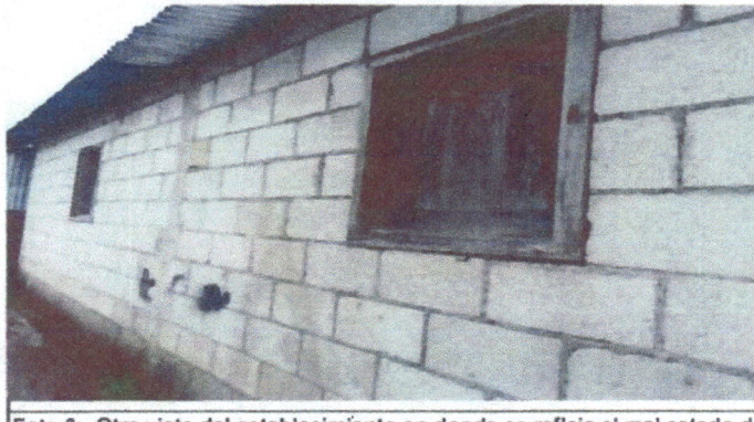
Foto 6: Otra vista del establecimiento en donde se refleja el mal estado de las laminas y la necesidad de cambio de ventanas.
